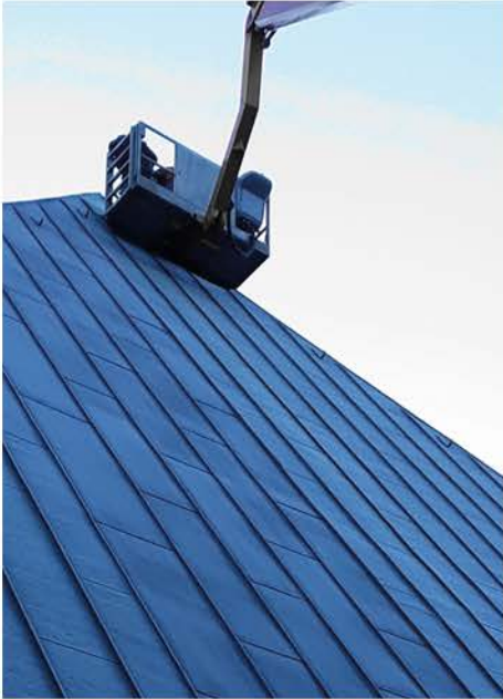
Reparatur am Dach der Marienkirche
